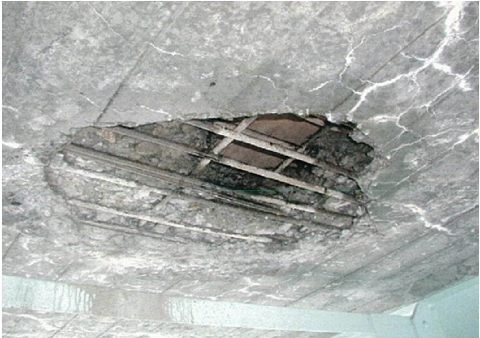
敷き鉄板設置完了（床版下面より）
