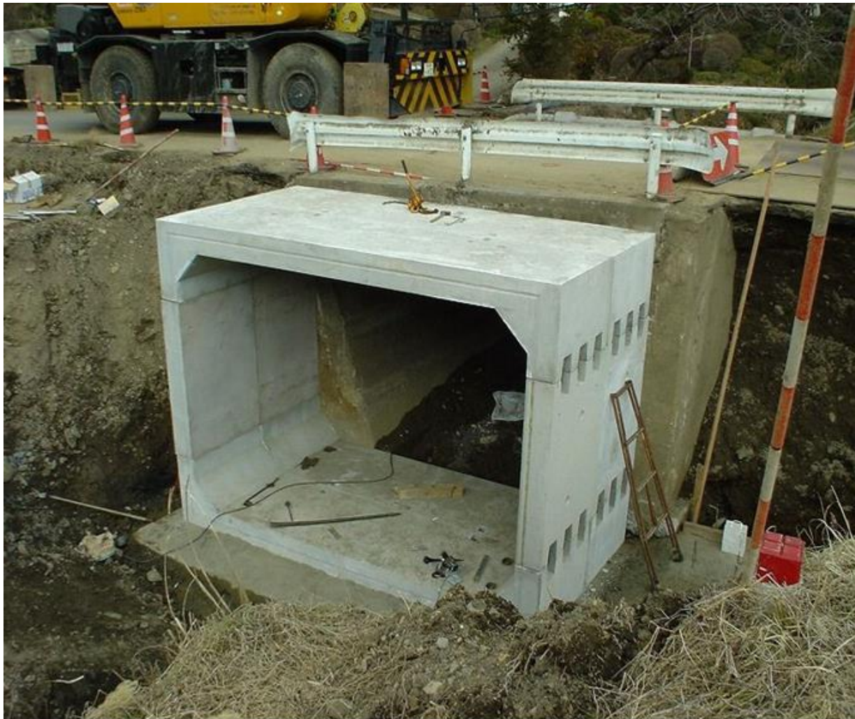
BOXカルバート橋 施工の様子
