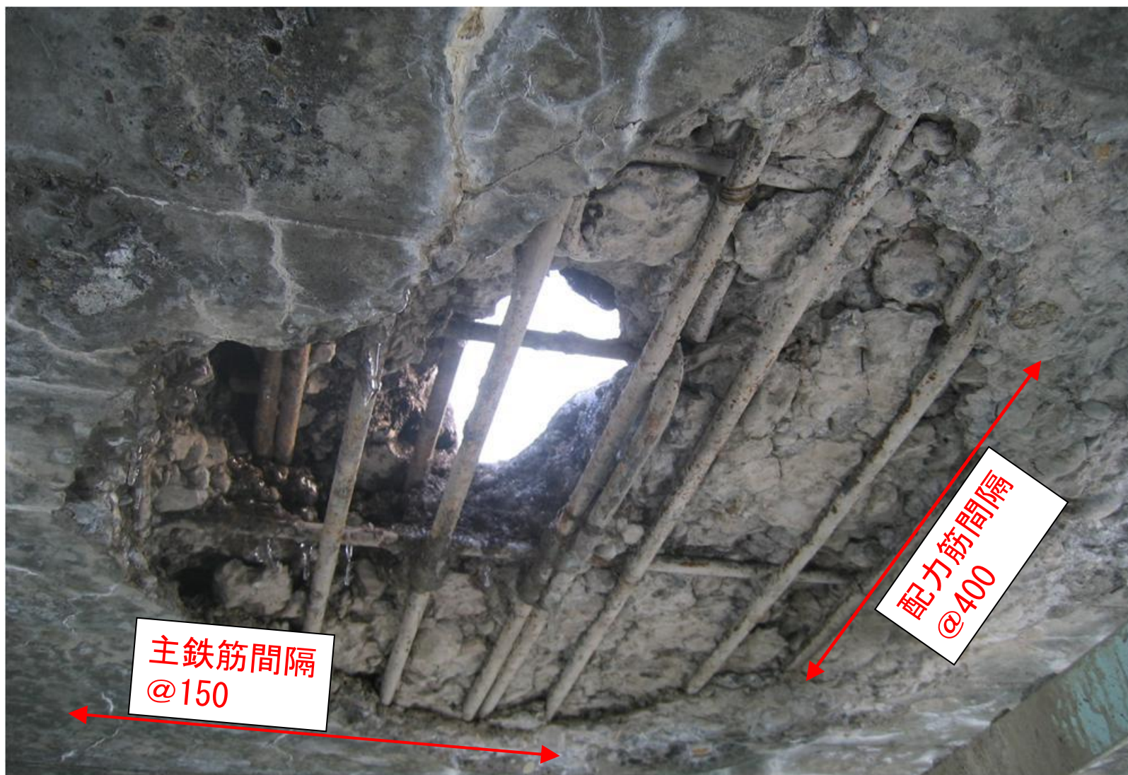
床版下面の状況
