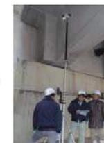
ロボットカメラ(高所型)を用いた桁端部のモニタリング状況
