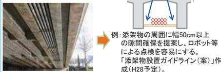
例: 添架物の周囲に幅50cm以上の隙間確保を提案し、ロボット等による点検を容易にする。「添架物設置ガイドライン(案)」作成(H28予定)。
