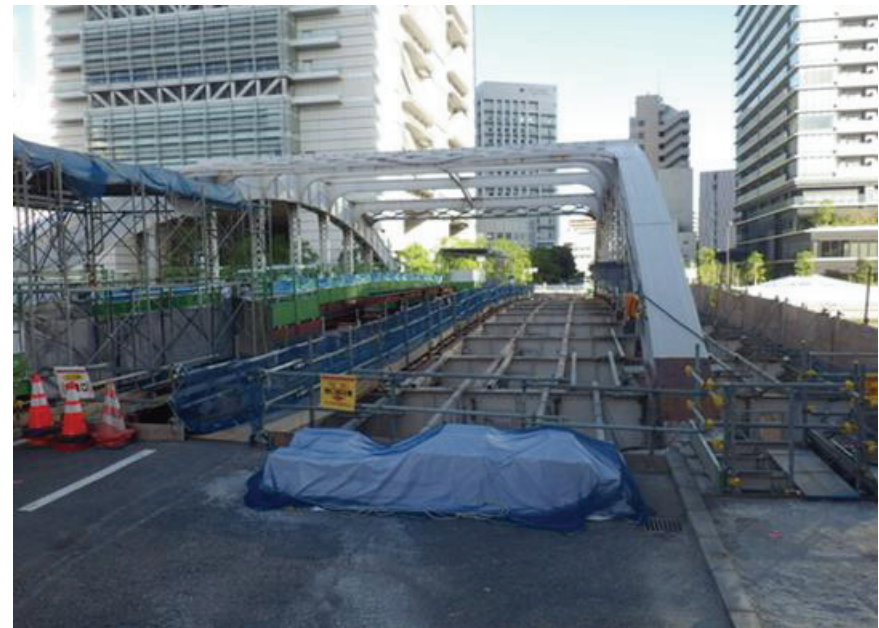
路面状況(右岸)
